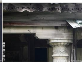
步口柱上為 RC 梁搭配木造封簷板
