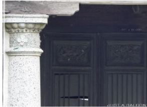
步口柱上為 RC 梁搭配木造封簷板
