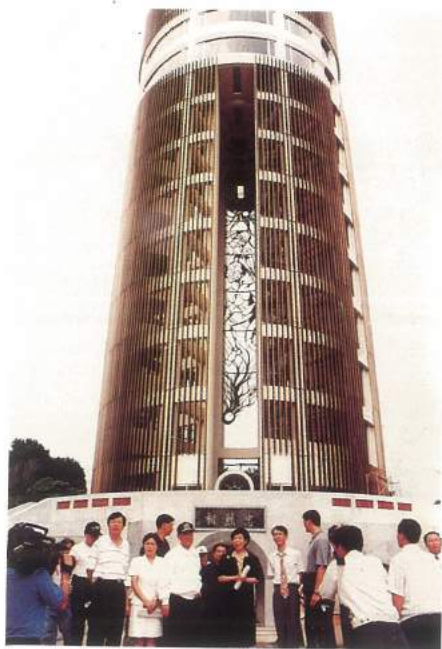
張市長陪同宋省長楚瑜視察忠烈祠暨射日塔興建工程現場
