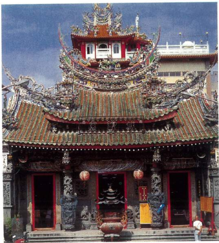
⑦民國69年(西元1980年)嘉義城隍廟後殿重建後之外貌全景。
