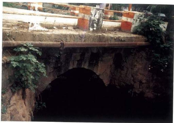
圖七、芳草橋全貌。
