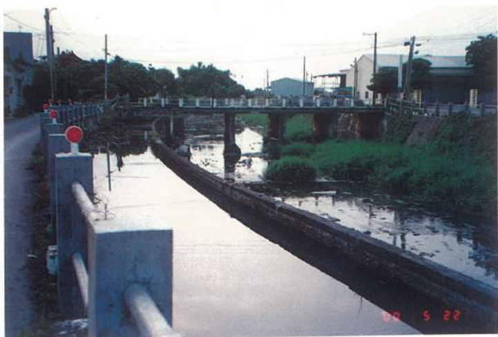
整治後的打死人埤，目前已成嘉義中央大排水溝西岸（圖左欄杆下）為圳道，東岸（圖右下方）為排水道，其設計頗具匠心，溝上架水泥橋，已無往昔撐筏渡埤的情景。
