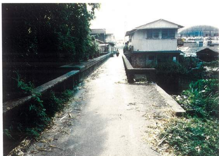
照片二 水閘上水泥橋
