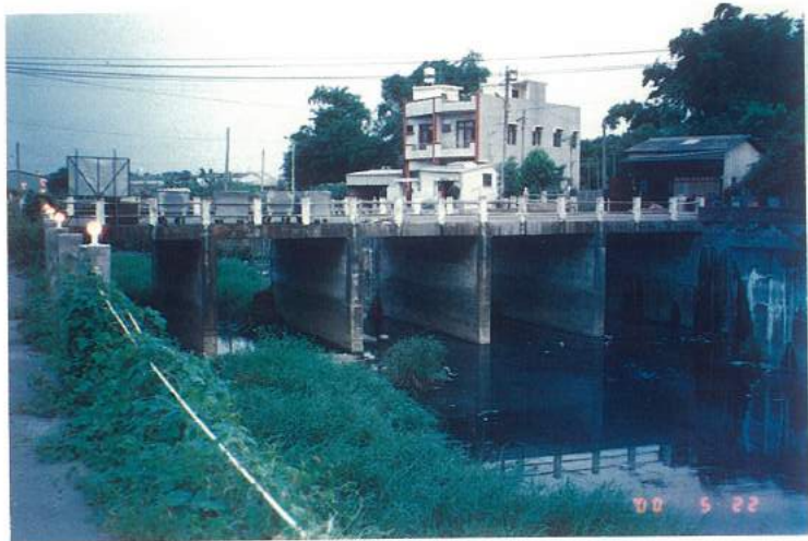
圖為島岫仔下埤間來往必經的中央大排水溝上的水泥橋，右方為島岫仔，左方通下埤、頂埤、北社尾。
