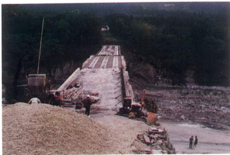
行圓橋施工情形之一， 業於87年5月完工通車。
