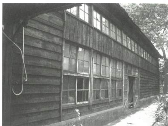
圖 4：（左圖）辦公室背向外觀、（右圖）辦公室之雨淋板壁體
