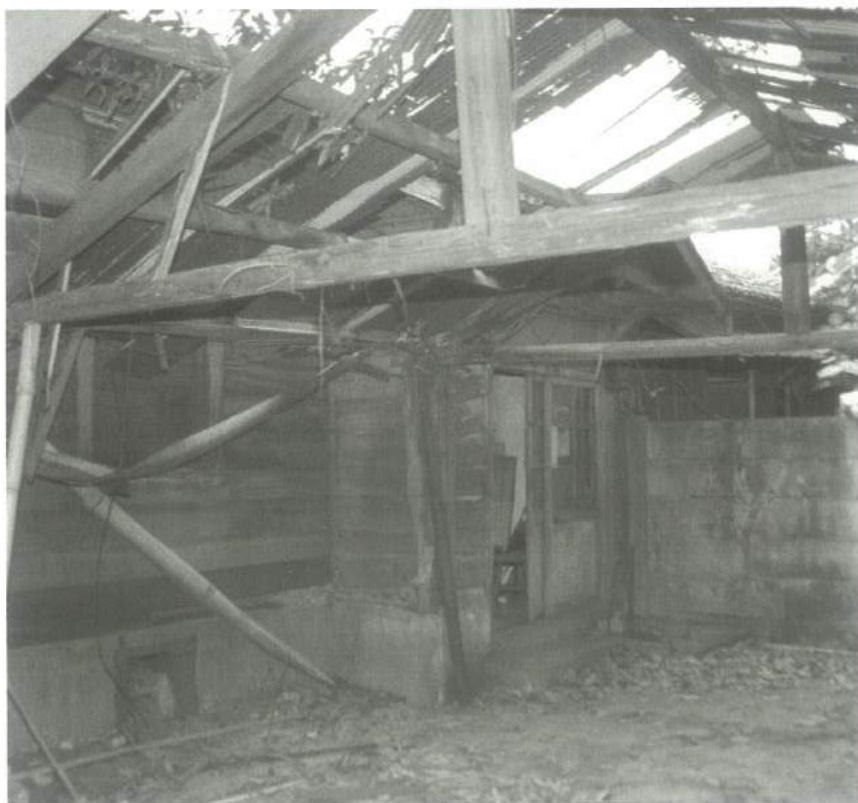
圖 2：所長官舍入口門廊與應接室外觀，牆面採西式雨淋板與上下開窗
