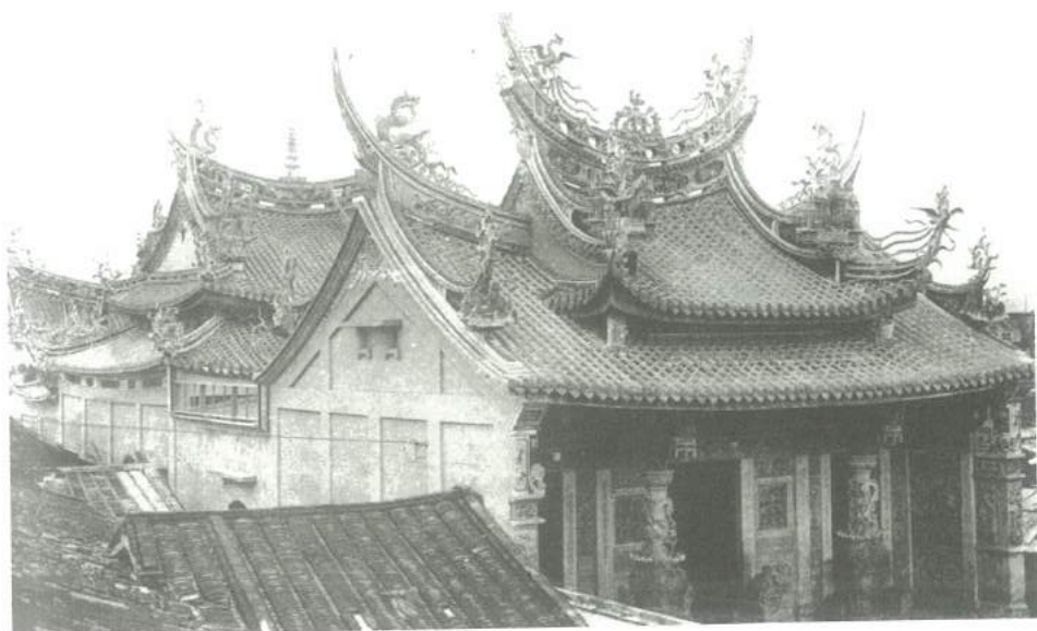
▲嘉義城隍廟。於 1715（康熙 54）年由諸羅知縣周鍾瑄捐俸創建，歷經多次整修。本照片所示係 1936（昭和 11）年重建，至 1940（昭和 15）年竣工，由泉州溪底派匠師王錦木承包，屬典型的街尾式廟宇配置。
