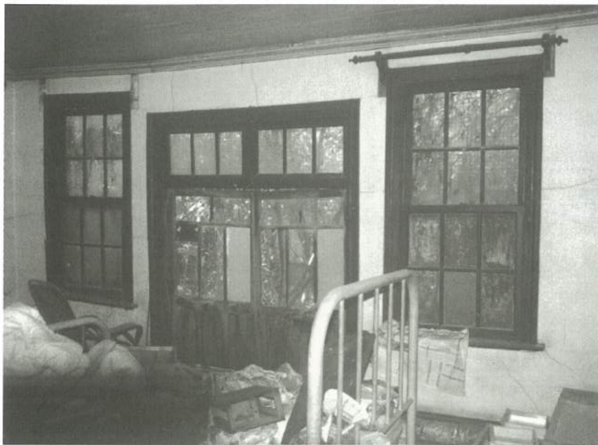
圖 3：所長官舍應接室室內，可見到西式上下開窗與窗簾架
