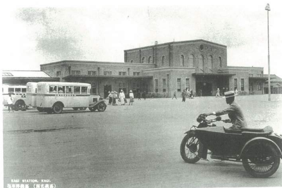
▲ 第二代嘉義驛（嘉義火車站），建造於 1933（昭和 8）年，屬折衷建築式樣，為鋼筋混凝土結構，古典風格的對稱方式，簡化的山牆及幾何圖案裝飾，呈現水平簡潔的現代感。
