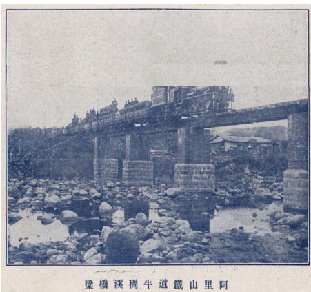
左 / 圖 7：採用木造上承床版式豪氏桁架梁（Howe Truss Deck Bridge）之第一代牛稠溪橋
