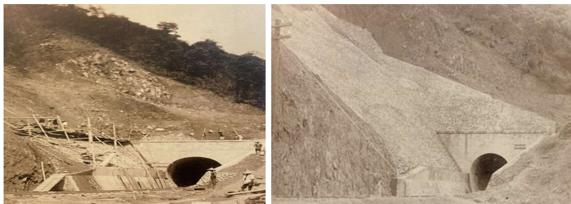
圖 20：延用阿里山鐵路採用特殊混凝土構造設計之下部基礎角隅部擋土牆的宜蘭線鐵路第三雙溪隧道口護坡工程施工（左）與完工（右）一景。
