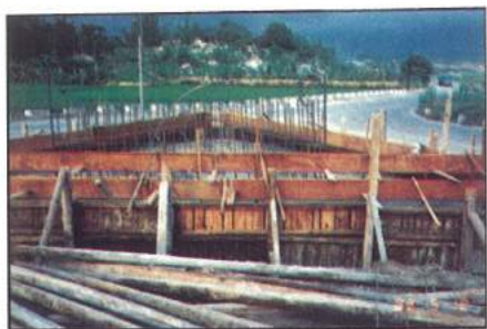
▲工程打下100噸的混拌水泥地基。
